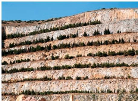
Λατομείο ασβεστόλιθου που εξορύσσεται για παραγωγή τοιμέντου στο Νομό Θεσσαλονίκης, μετά τη φύτευση δενδρυλλίων τα οποία βρίσκονται υπό ανάπτυξη.
